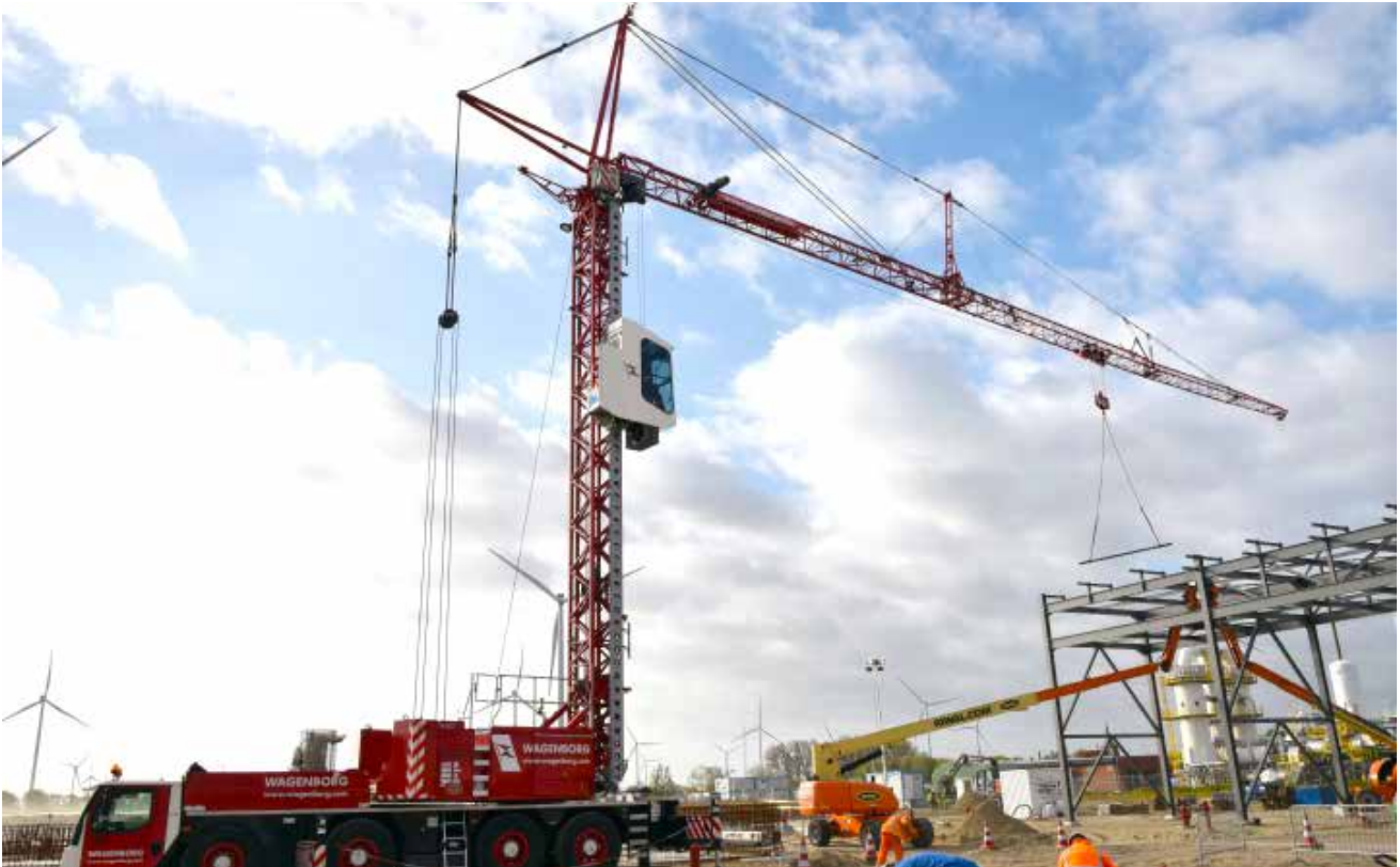
Mobiele torenkraan Liebherr
